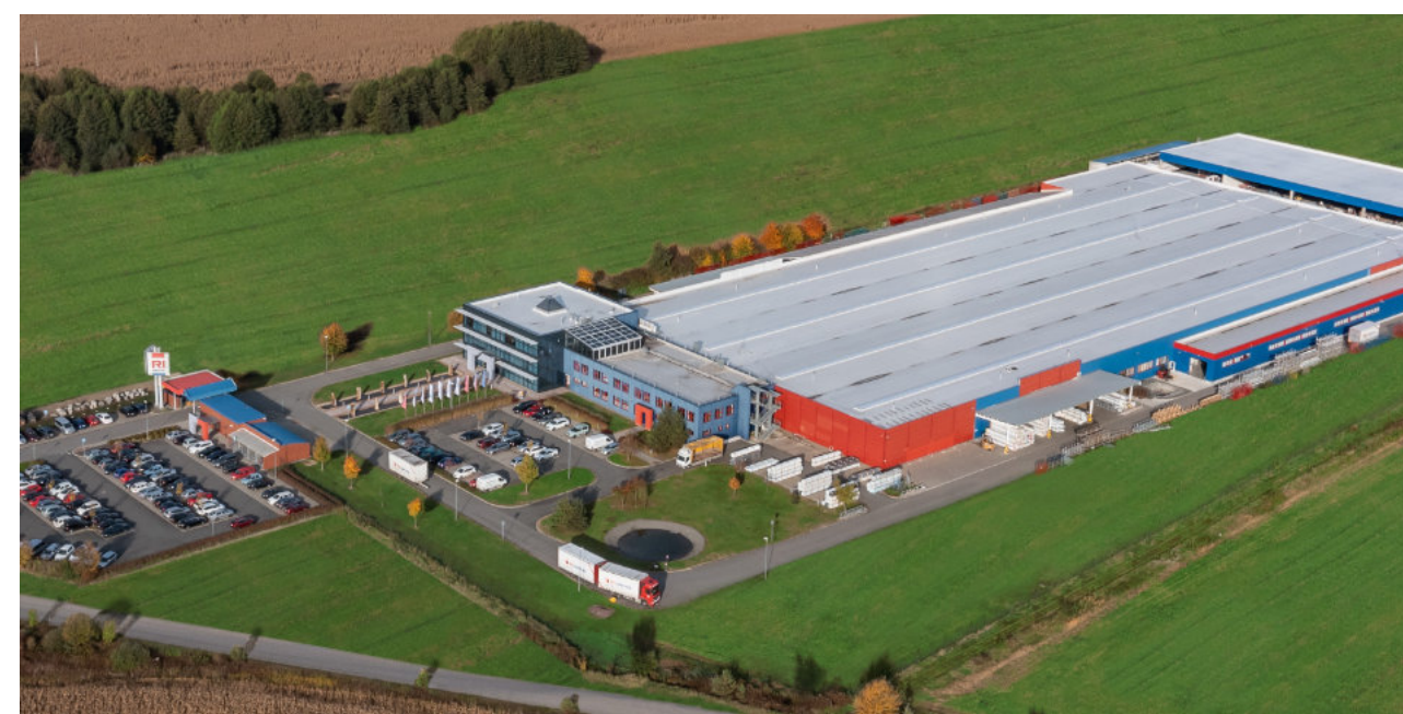
Administrativní budova/výroba plastových oken, Bažantnice, Bzenec
